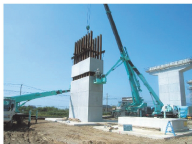
橋脚急速施工 ～九州新幹線(熊本県)
