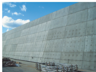
防波壁高上げ施工
