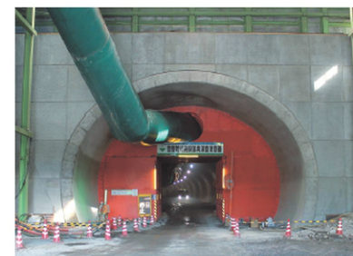
トンネル坑門化粧パネル SEEDフォーム(O)、製品厚:60mm
